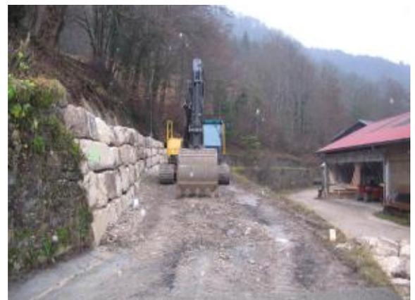
La voie communale en amont de la Scierie NEYRON était très dangereuse en hiver à cause des eaux de ruissellement. Le drain posé derrière l'enrochement permet de canaliser l'eau et sécurise la route en cas d'intempéries.
